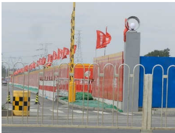
2017 年北京市人民政府の「遷都」 (移転先 : 通州区) 現在工事中
